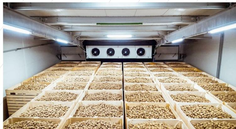
Необходимые параметры хранения поддерживаются автоматической системой контроля вентиляции, увлажнения, охлаждения и обогрева. Регулирование степени открытия клапанов осуществляется электроприводами, автоматически изменяющими угол открытия в зависимости от температуры.
