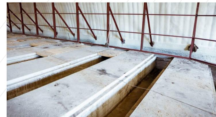
**ПРИ ПРИМЕНЕНИИ ТЕХНОЛОГИИ ПЕРФОРИРОВАННЫЕ ВОЗДУХОВОДЫ, СИСТЕМА ВЕНТИЛИРОВАНИЯ ОБЕСПЕЧИВАЕТ ЦИРКУЛЯЦИЮ ВОЗДУХА ЧЕРЕЗ НАСЫПЬ ПРОДУКЦИИ, С ПОМОЩЬЮ ВОЗДУШНЫХ НАПОЛЬНЫХ КАНАЛОВ, РАВНОМЕРНУЮ ТЕМПЕРАТУРУ И ВЛАЖНОСТЬ В ОБЪЕМЕ ПРОДУКЦИИ, А ТАКЖЕ ЗАМЕЩАЕТ ИЗБЫТОК УГЛЕКИСЛОГО ГАЗА И ДРУГИХ ПРОДУКТОВ ДЫХАНИЯ ОВОЩЕЙ СВЕЖИМ ВОЗДУХОМ.**
