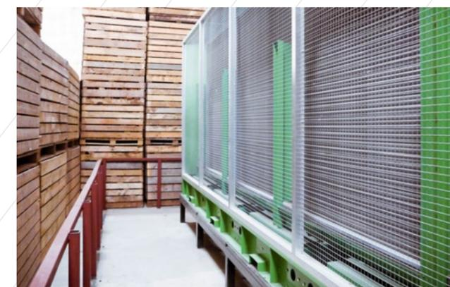
**ТЕХНОЛОГИЯ НАПОРНАЯ СТЕНА ПРИМЕНЯЕТСЯ ТОЛЬКО ПРИ КОНТЕЙНЕРНОМ ХРАНЕНИИ ОВОЩЕЙ И ЯВЛЯЕТСЯ ОДНОЙ ИЗ НАИБОЛЕЕ ЭФФЕКТИВНЫХ. ДЛЯ ДАННОГО СПОСОБА ХРАНЕНИЯ ПОДХОДЯТ ПРЯМОСТЕННЫЕ ЗДАНИЯ ИЗ ЛСТК И СЭНДВИЧ-ПАНЕЛЕЙ.**
