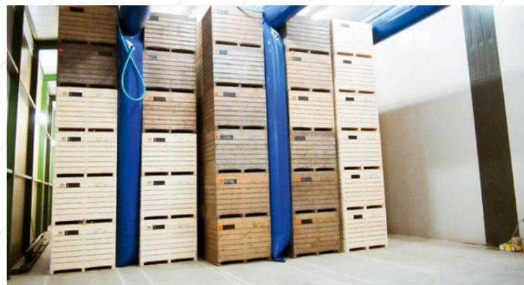
**ИСПОЛЬЗОВАНИЕ ТЕХНОЛОГИИ DRAGON СОЗДАЁТ НЕОБХОДИМЫЕ УСЛОВИЯ ДЛЯ ДОЛГОСРОЧНОГО ХРАНЕНИЯ ОВОЩЕЙ.** ДАННАЯ ТЕХНОЛОГИЯ ОБЕСПЕЧИВАЕТ ОХЛАЖДЕНИЕ, ЦИРКУЛЯЦИЮ ВОЗДУХА ВНУТРИ ХРАНИЛИЩА И РАВНОМЕРНОЕ ТЕПЛО-ВЛАЖНОСТНОЕ ПОЛЕ, А ТАКЖЕ ЗАМЕЩЕНИЕ ИЗБЫТКА УГЛЕКИСЛОГО ГАЗА (CO<sub>2</sub>) И ДРУГИХ ПРОДУКТОВ ДЫХАНИЯ СВЕЖИМ ВОЗДУХОМ.
