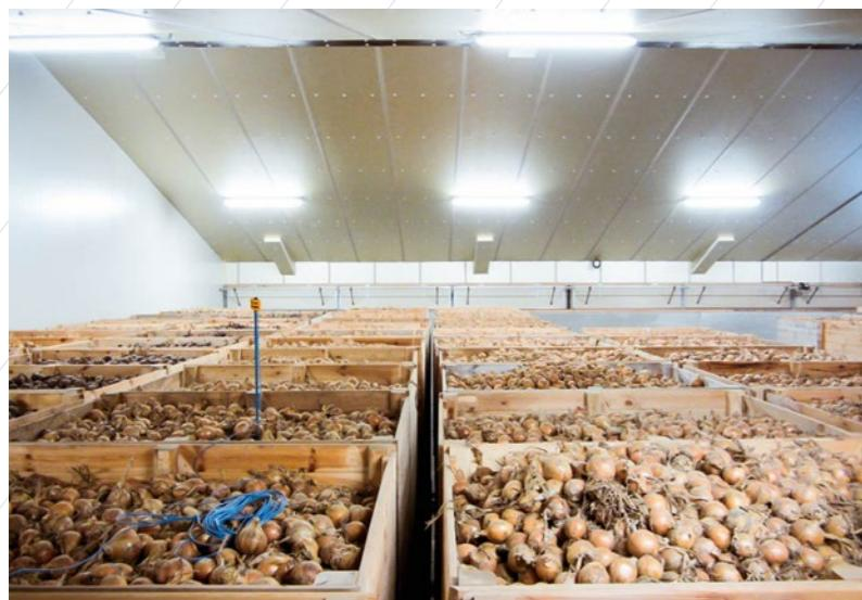
стене. Вентиляторами создается напор воздуха, который через проемы стены попадает в проемы контейнеров, проходя через продукт. Торцевые проемы контейнеров крайнего ряда закрываются специальными шиберами. Тем самым, воздух вынужден проходить через толщу продукта. Для данной технологии важно применение специализированных контейнеров (стандартный европейский овощной контейнер для систем активного вентилирования размерами 1,6 x 1,2 x 1,2).
