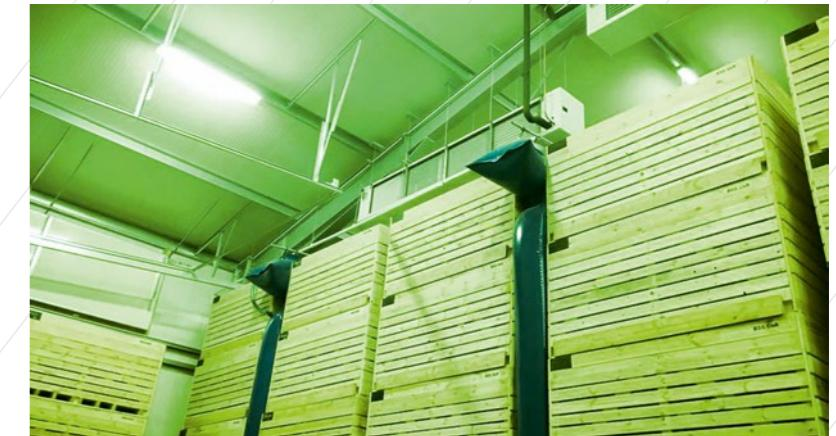
вращая усушку продукции. Крайне важно в воздухоохладителях иметь минимальный перепад разницы температур, не более в 6 градусов (Dt6k), т. е. температура кипения фреона должна быть на 6 градусов ниже, чем температура в камере.
